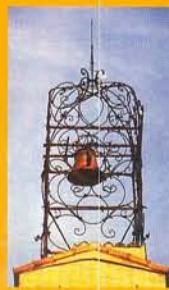
La Tour de l'Horloge : Tour du X l ème siècle avec un campanile en fer forgé du XV l ème siècle bâtte au cœur du village.
