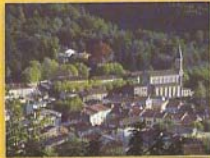
VOIE DU VILLAGE
